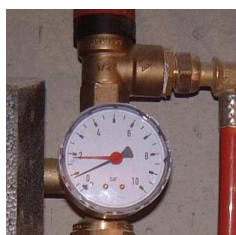
Manomètre indiquant la pression du circuit
